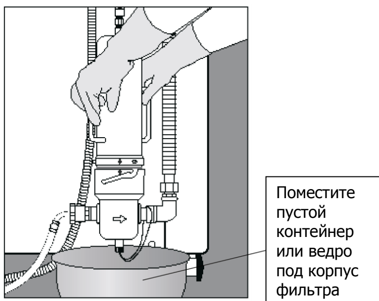
Рис. 69. Установка пустого контейнера под корпусом фильтра
